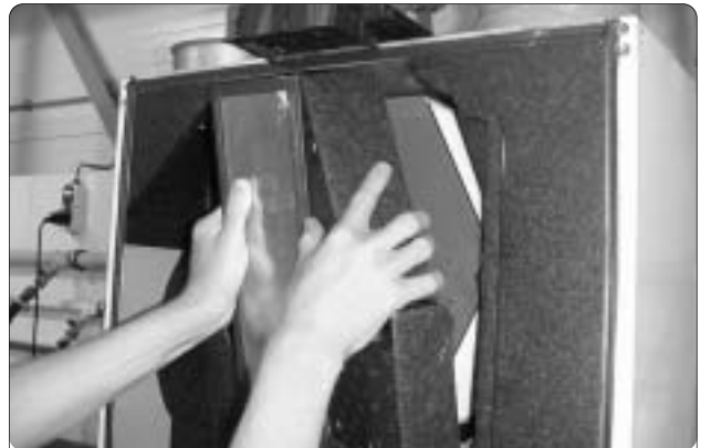
Figuur 15-4. Verwijderen bypass.
