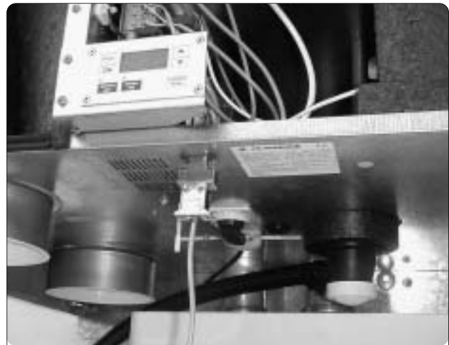
Figuur 15-11. Aansluiten communicatiestekker.
